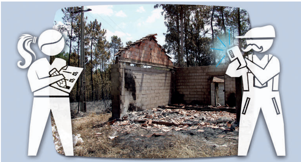
Fig. 77 Avalie os danos no edificado.
